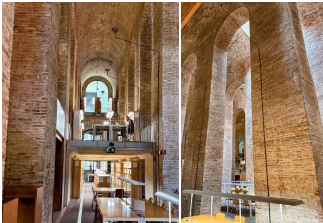
Dipòsit de les Aigües – intérieur.
