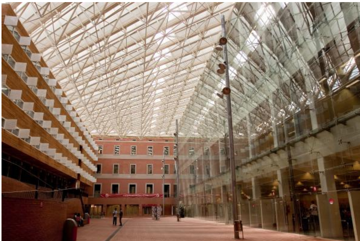
Cour couverte d'une verrière et salles pour les séances scientifiques dans le bâtiment Roger de Llúria sur le campus de la Ciutadella de l'UPF.
